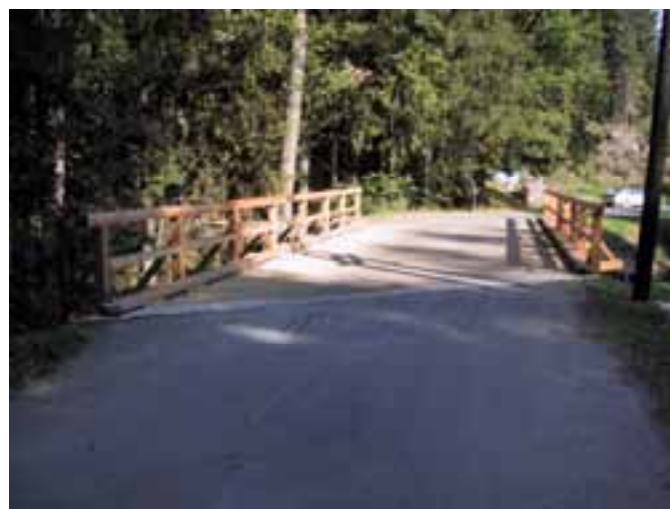
Sanierung Elexenbachbrücke nach Gr. Höbarten
