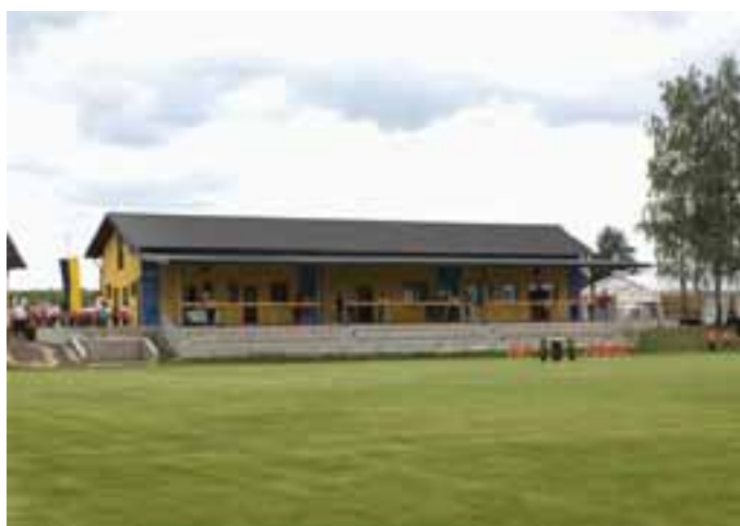
Neubau Kabinen und Tribüne SCU Koller Nondorf
