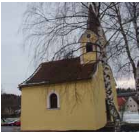
Sanierung Kapelle Großhausgemeinde Nondorf
