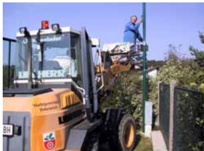
Sanierung der Straßenbeleuchtungskörper
