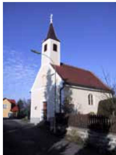
Sanierung Kapelle Kleinhausgemeinde Nondorf
