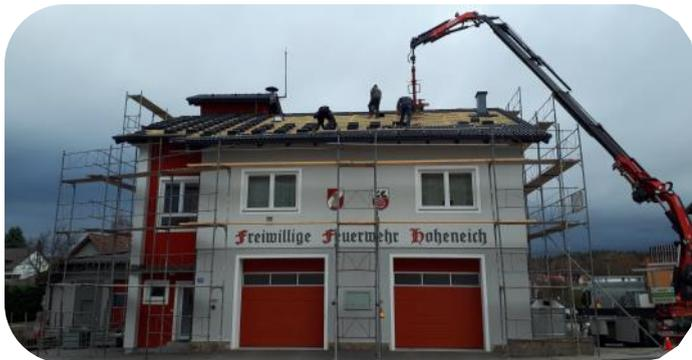
Im November wurden am Bauhof in Hoheneich und auf dem FF-Haus in Nondorf Photovoltaikanlagen montiert. Für die Errichtung einer Photovoltaikanlage am FF-Haus in Hoheneich wurde zuerst das Dach saniert. Sobald es die Wetterlage zulässt, wird auch hier die Anlage montiert.
